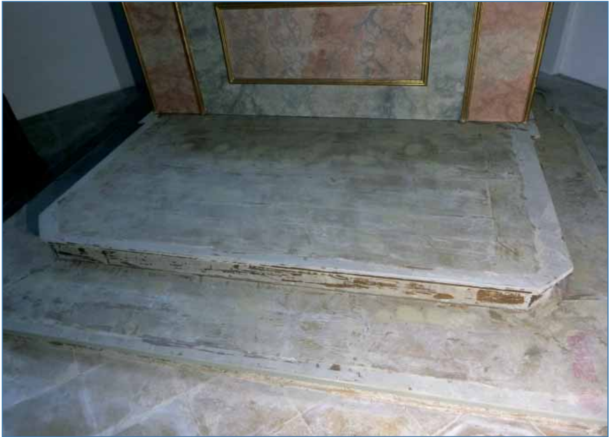
Podest und Stufen des Hochaltars schauen sehr schlimm aus! Der Teppich wurde vollflächig verklebt, der Kleber wurde dick mit der Zahnpachtel aufgetragen. (22. Nov. 2021)
