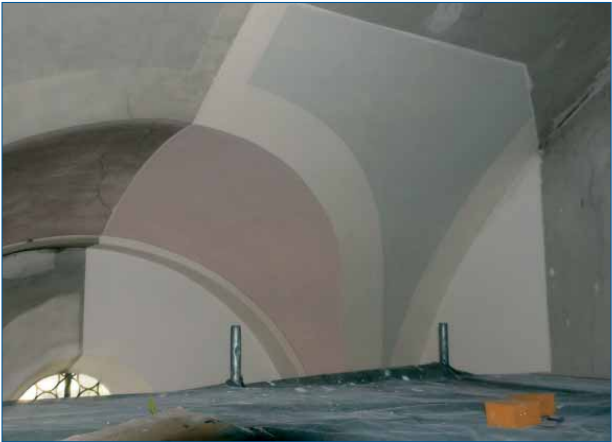
Die fertiggestellte Musterfläche oberhalb des Marienaltars verdeutlicht eindrucksvoll den Unterschied zwischen der frischen Farbe und der Verschmutzung außen herum. (20. Aug. 2021)
