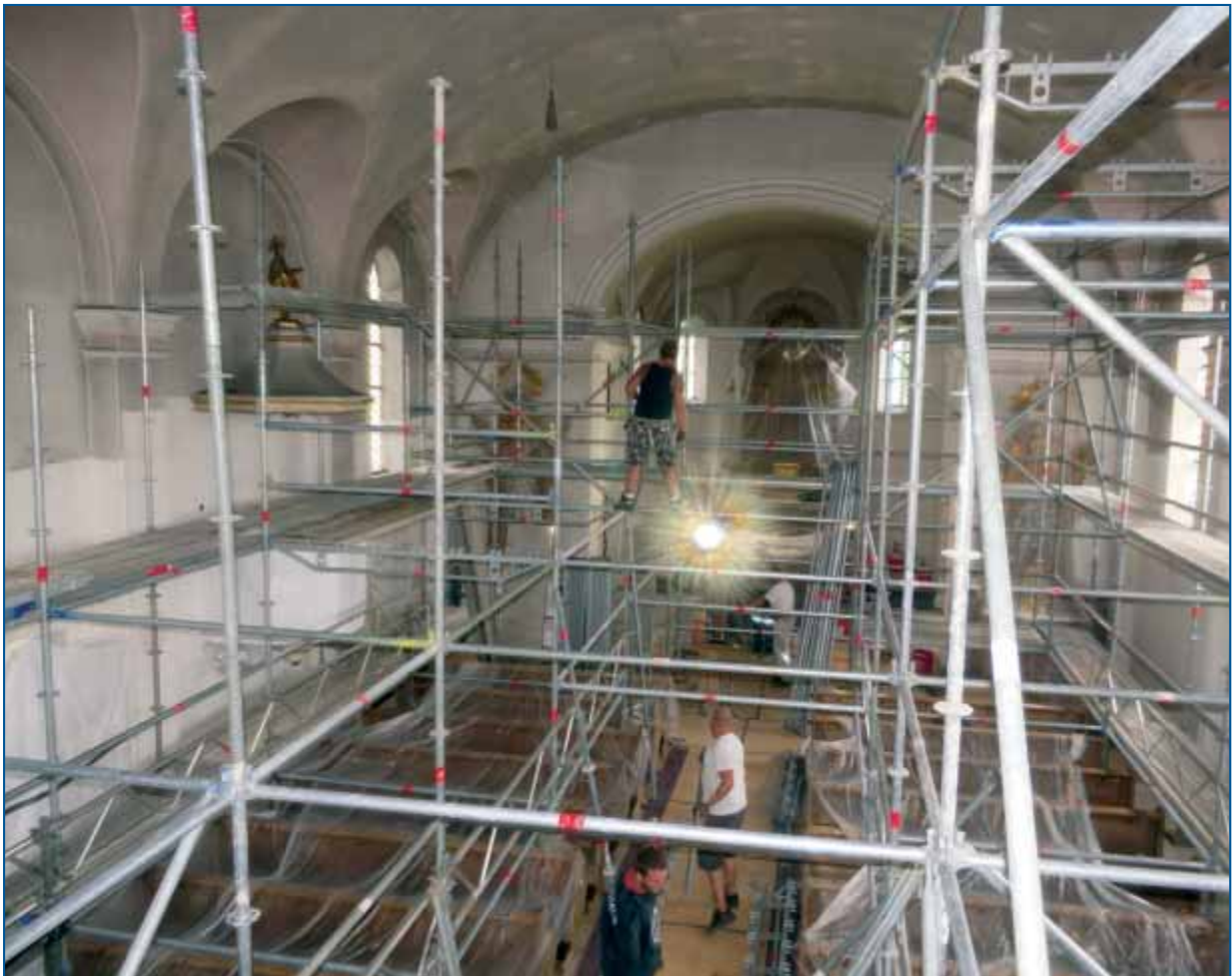
Oben: Blick von der Empore nach vorne zum Hauptaltar. Gut zu sehen: links die bereits teilweise gesäuberten Wände im Kontrast mit dem noch nicht gereinigten Gewölbe.
