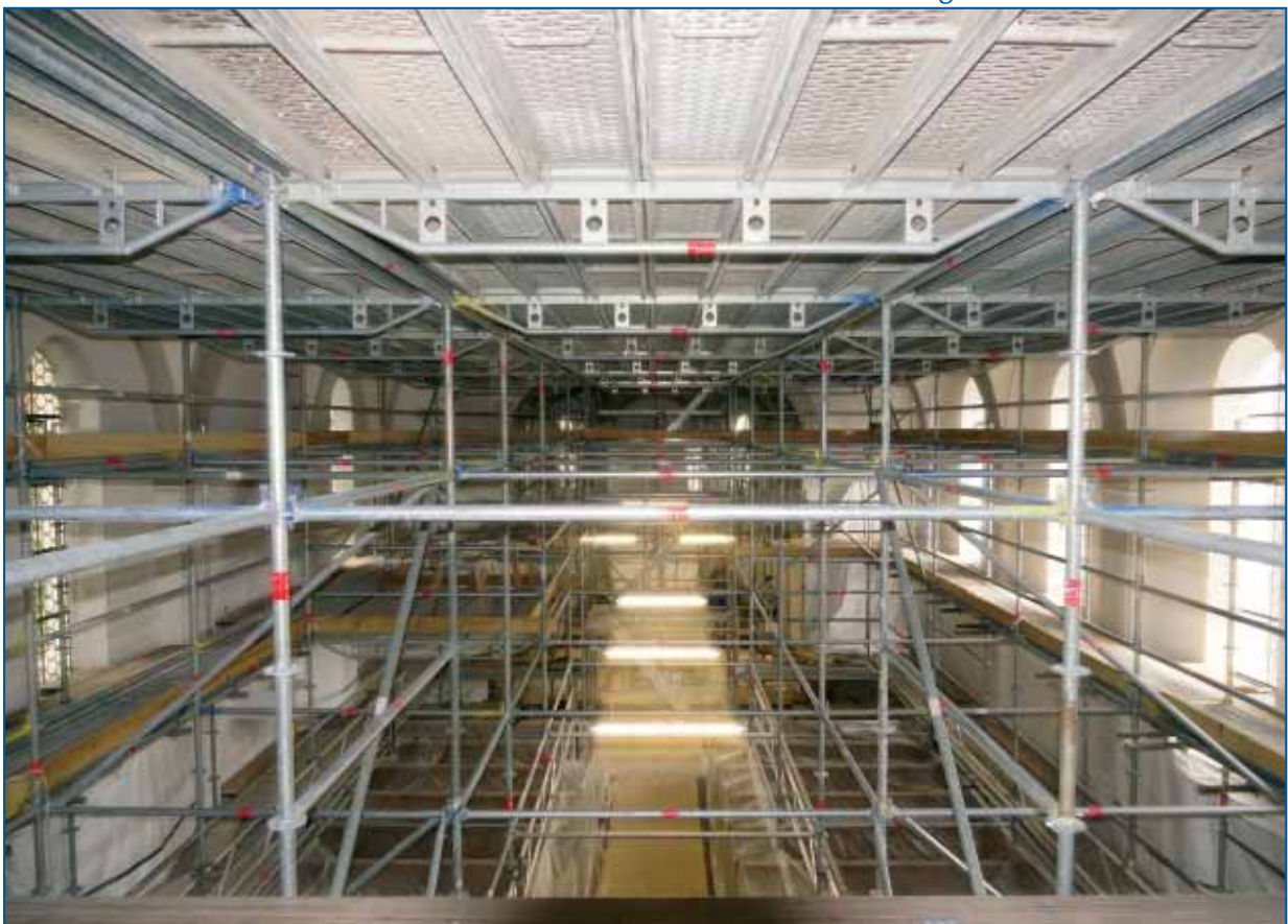
Unten: Blick von der Empore nach vorne zum Hauptaltar. Am oberen Bildrand ist das „Oberdeck“ des Gerüsts zu sehen, von wo aus das Gewölbe gut zu erreichen ist.
