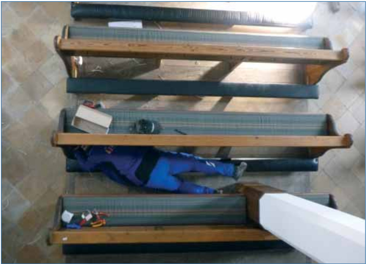
Blick von der Emporenbrüstung nach unten zu dem Elektriker, der gerade die neue Sitzheizung einbaut. (18. Nov. 2021)
