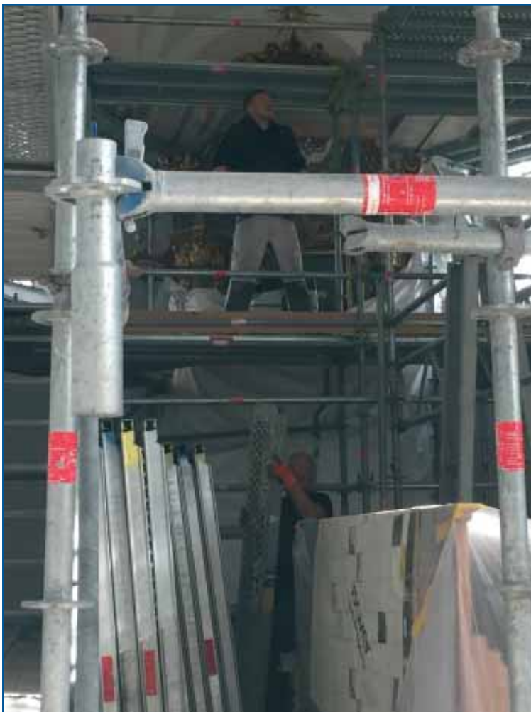
Die Gerüstbauer beginnen mit dem Abbau des Arbeitsgerüsts. (25. Okt. 2021)
