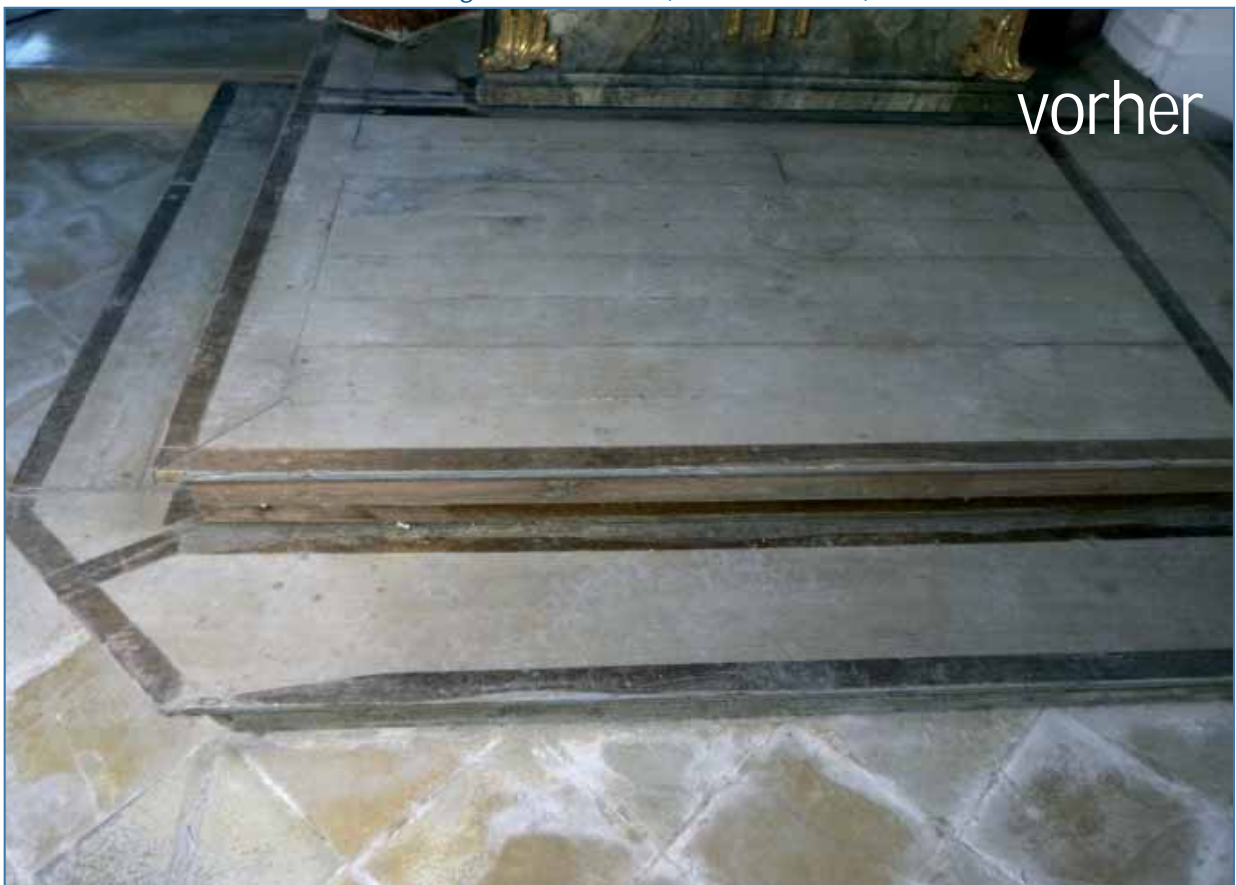
Podest und Stufen des Josefsaltars nach der Entfernung des alten Teppichs. Deutlich sieht man die Reste der Klebebänder, mit denen der Teppich wohl „für die Ewigkeit“ befestigt worden ist. (22. Nov. 2021)
