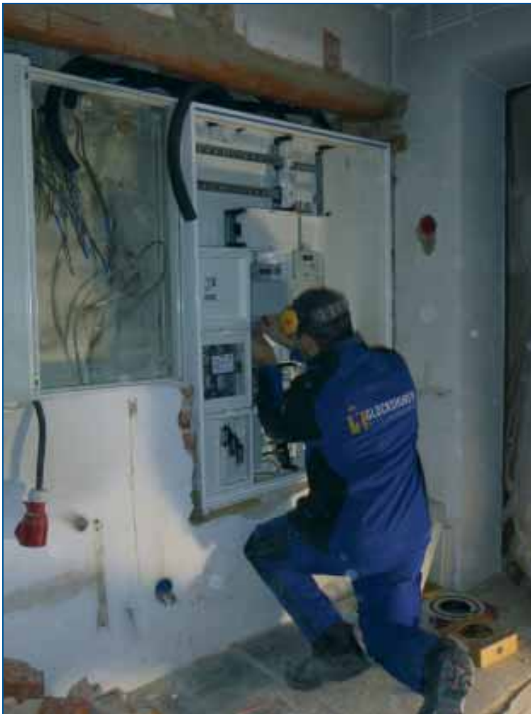
Der neue Sicherungskasten wird eingebaut, neue Stromzähler ebenso, die alten Kästen sind entfernt. (22. Okt. 2021)
