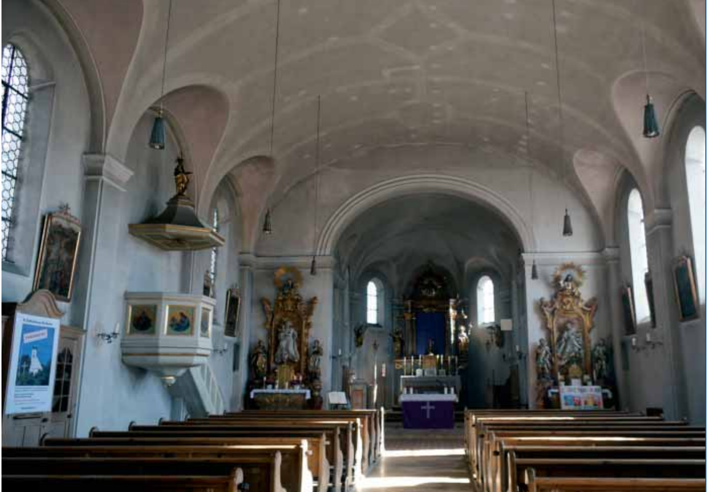
Zustand der Kirche vor Beginn der Reinigung: Deutlich ist die Verschmutzung der Wände zu erkennen und die unsachgemäßen Flecken am Gewölbe.
